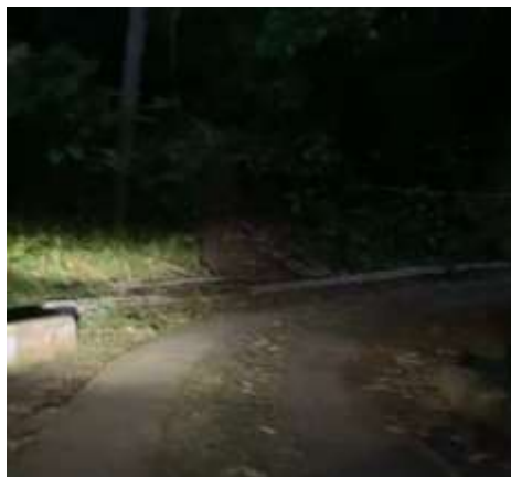
Gambar 2. Kondisi Jalan yang Minim Penerangan.
