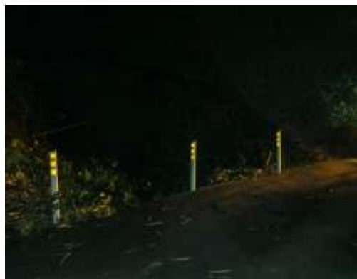
Gambar 4. Pemasangan Reflektor Jalan.
