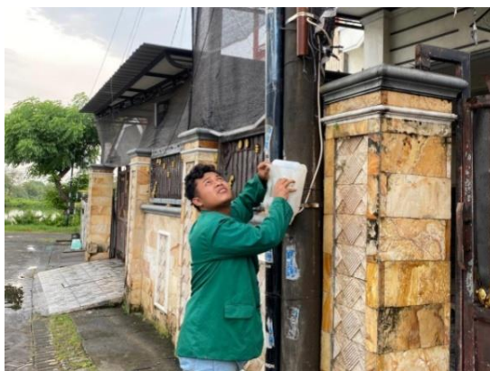
Gambar 3. Perbaikan Lampu di akses Jalan terjadinya konsleting pada Arus Kabel.
