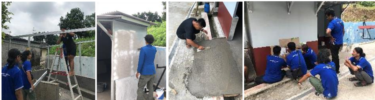
Gambar 6. Proses Pembangunan Gudang Bank Sampah “Nuri”
