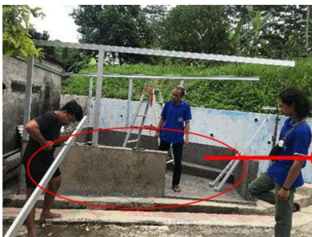
Gambar 5. Pemasangan kolom baja ringan pada dinding eksisting
