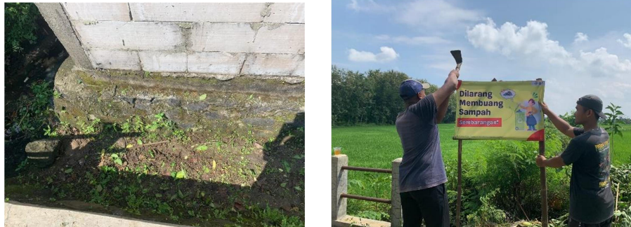
Gambar 5. Pembersihan talud dan pemasangan banner
