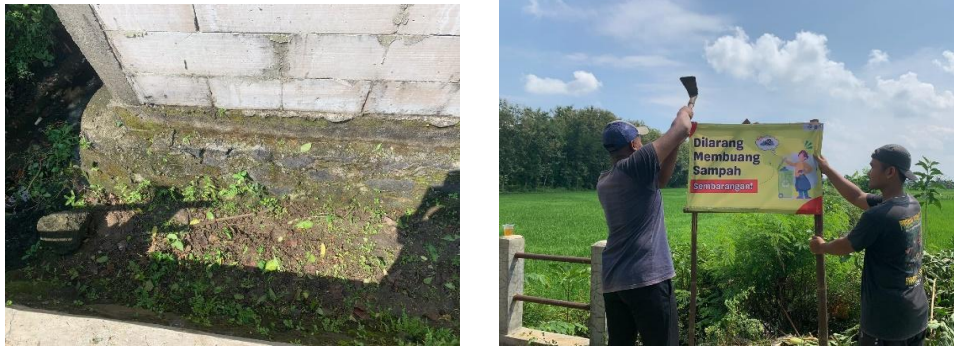
Gambar 5. Pembersihan talud dan pemasangan banner
