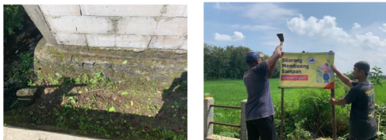
Gambar 5. Pembersihan talud dan pemasangan banner
